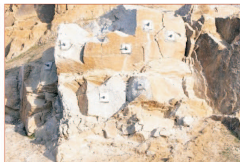
Stahlplatten bilden den Abschluss der Felssicherung. Dahinter befinden sich Stahlstäbe, die mit Zement befestigt wurden.
