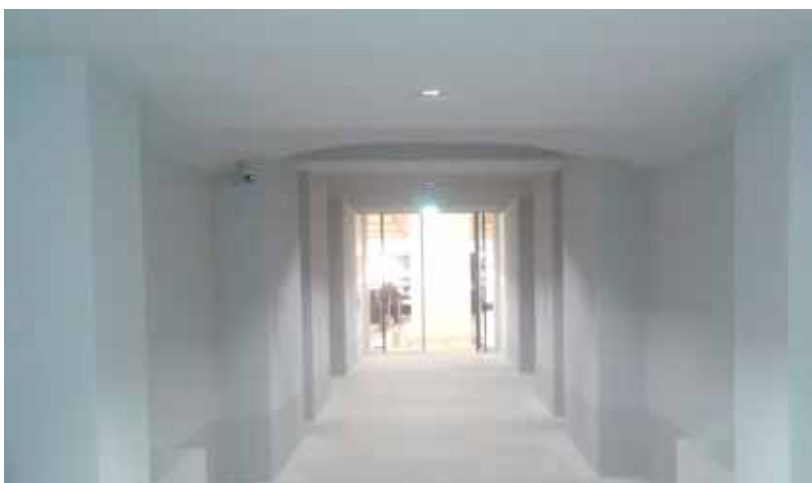
Besuchertunnel nach Fertigstellung. Im April 2015 wurden die Bauarbeiten der Jähinig GmbH an der Tunnelerweiterung im Rohbau abgeschlossen. Sämtliche Bauarbeiten erfolgten während des laufenden Museumsbetriebes. Durch andere Gewerke folgt der komplette Ausbau zu einem modernen Museums-gang. Rund 400.000 Besucher kamen 2013 in die Gemäldegalerie. Während der Bauarbeiten sind es nicht weniger geworden. Foto: Jähinig GmbH
