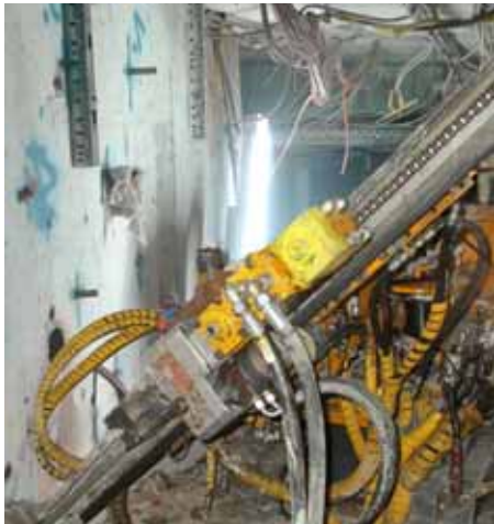
Herstellung der Injektionsbohrungen im vorhandenen schmalen Mediengang.
