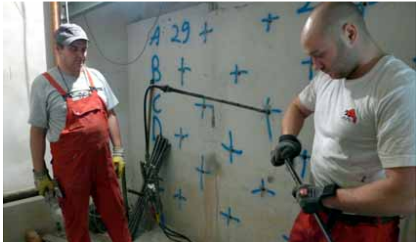
Durchführung der Injektion. Nach dem Rammen wurden die Lanzen abschnittsweise gezogen, währenddessen das Injektionsgemisch den Baugrund penetrierte. Es entstand ein säulenartiger Verpresskörper. Foto: TPH Bausysteme GmbH
